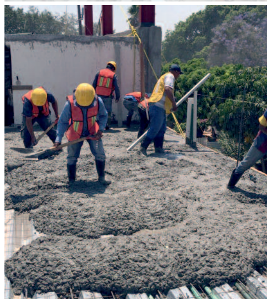
Urgenza d'amore: i lavori per la nuova Casa hanno avuto inizio.
